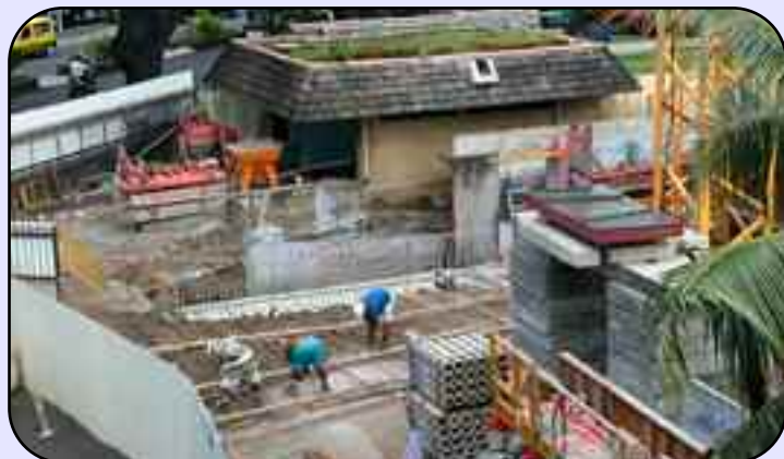
Travaux de construction de la station d'épuration communale située à l'Hôtel de ville
