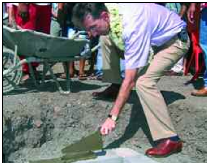
Olivier Jacob pose la première couche de ciment.
